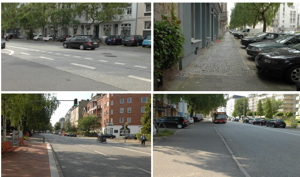
Abbildung 35: Holtenauer Straße im Bereich Kämpenstraße, Hanssenstraße, Homannstraße
