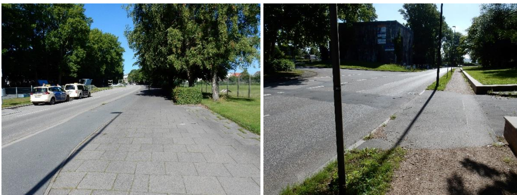
Abbildung 32: Kiellinie nördliche und südliche Fahrbahn im Bereich Schweriner Straße
