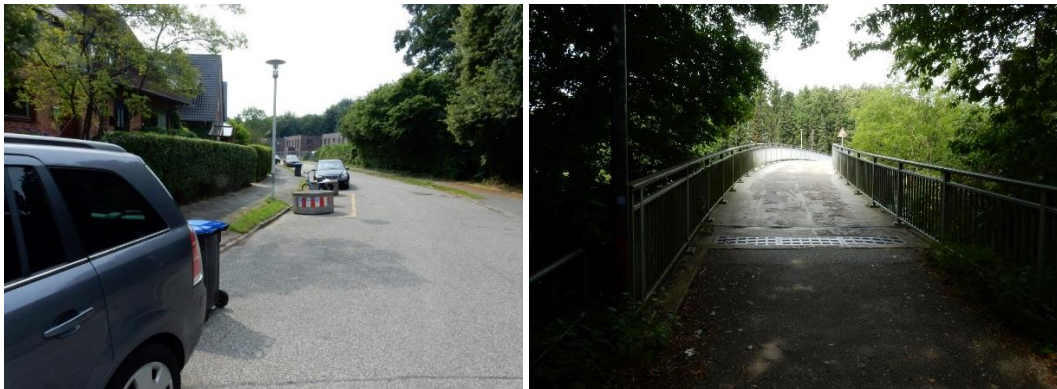
Abbildung 37: Flensburger Straße, Fußgängerbrücke
