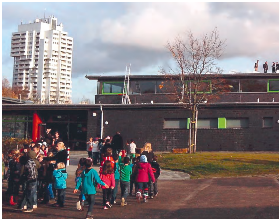
Sicht auf PV-Anlage Heidenberger Teich vom Schulhof
