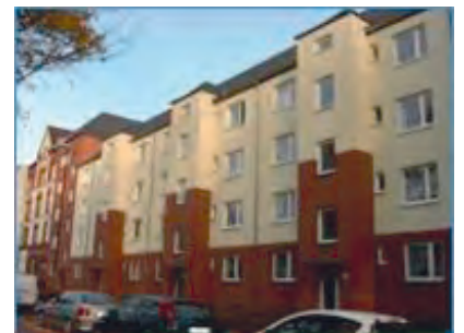
Fassadensanierungen verändern die ursprünglichen Backsteinfassaden
