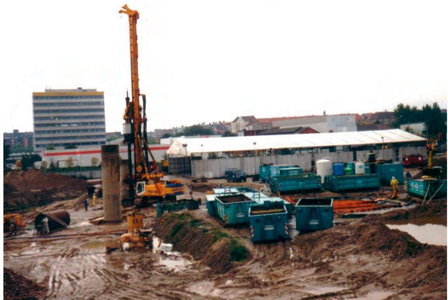
Sanierungsbaustelle Bereich K und E mit Großbohrgerät; ehem. Gaswerk und Öllager, Verunreinigungen durch Teeröl und Mineralölkohlenwasserstoffe
