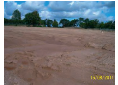
Gaswerk Wik I - Sanierungs- und Profilierungsmaßnahmen
