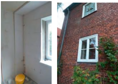
Innendämmung und neue Fenster im Pilotprojekt Hultschiner Straße
