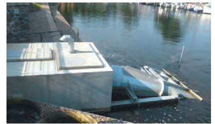
Wasserkraftnutzung mit Rohrturbine an der Schwentinemündung
