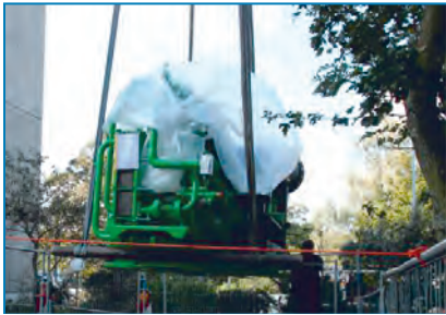
Einbau des Biogas-BHKW in das Heizhaus des Olympiazentrums
