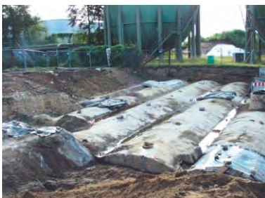
Gaswerk Wik I - Rückbau der Teergruben
