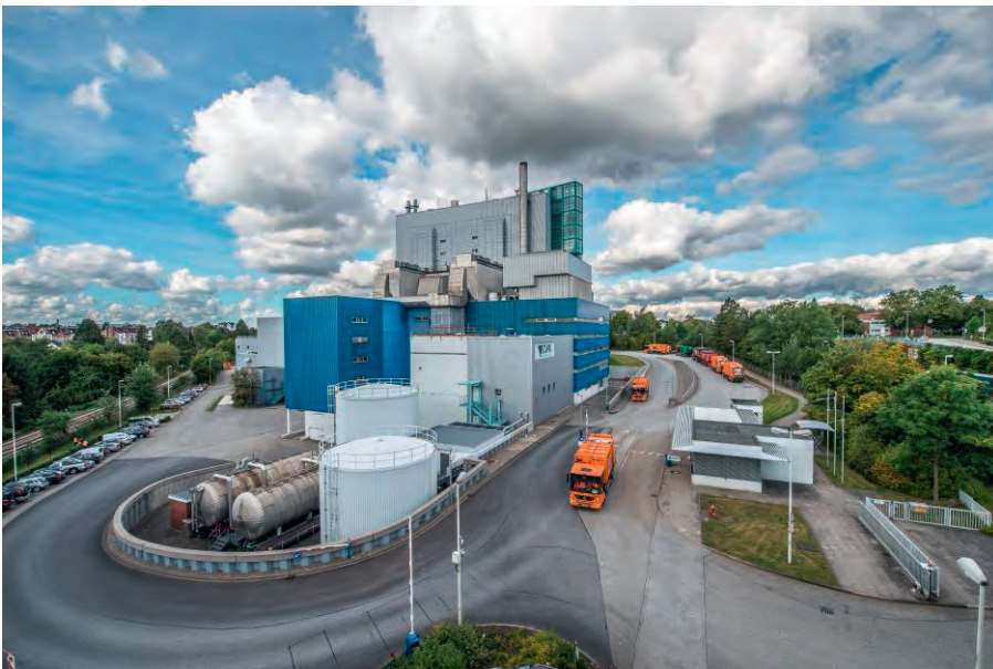
Betriebsgebäude der MVK (Foto MVK/Sven Janssen)
