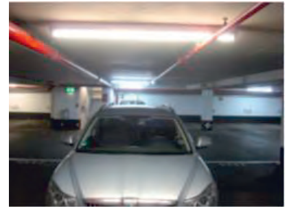
Umrüstung Tiefgarage auf LED-Beleuchtung mit „Intracting“-Mitteln
