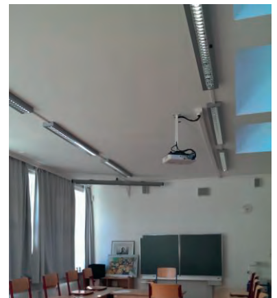
Neue LED-Spiegelrasterleuchten in den Klassenzeilen der Hebbelschule
