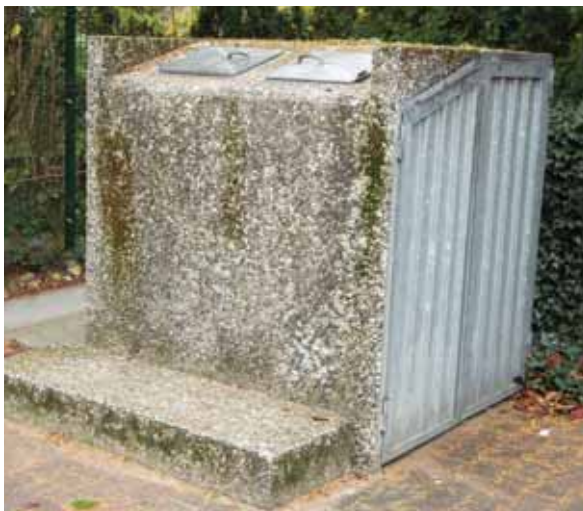
Abb. 6: Beispiel einer Einhausung vom Müllcontainer (Quelle: M. Wang)
